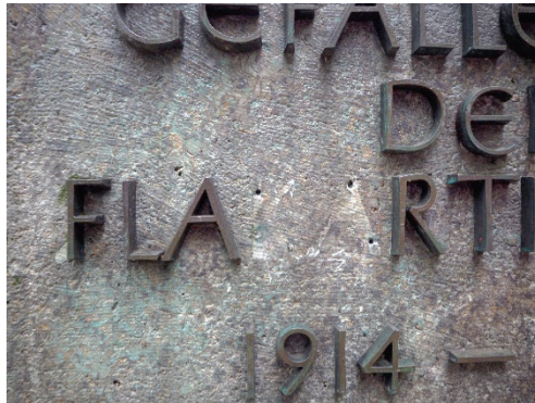
Bild 2 Das beschädigte Bogenschützenehrenmal Bild: Franz Hartmann
