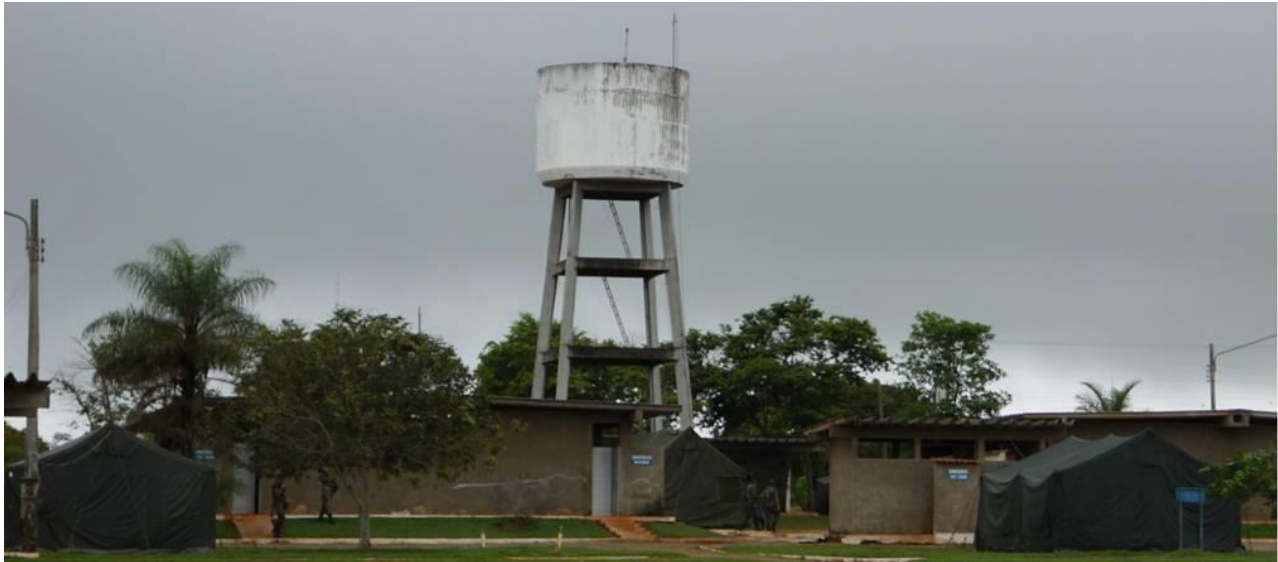
Das Camp mit dem Wasser-/ Fernmeldeturm – Foto Hackl
